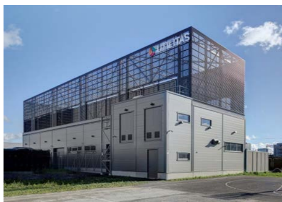
Utilitase uus kaugjahutusjaam
